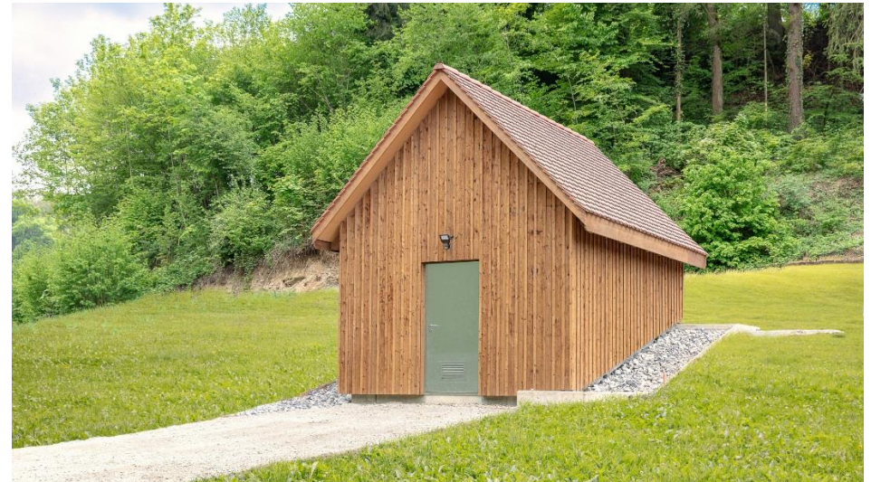
Neues Regenklärbecken, Birren
